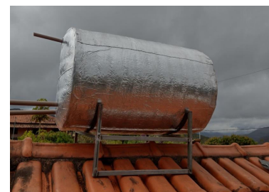
Figura 17: Suba com o reservatório no telhado e coloque-o em cima de um suporte. (Fonte: acervo Contraponto)
